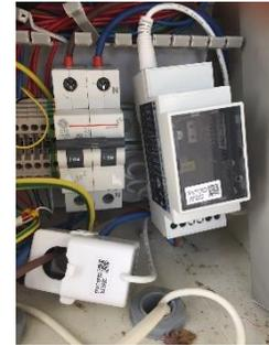
El sistema permite medir la tensión y corriente, así como potencia activa y reactiva, factor de potencia y el sentido de la corriente.
